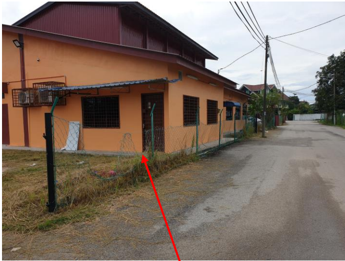
Pagar sedhada digantikan dengan pagar baru jenis 'welded mesh fence'
