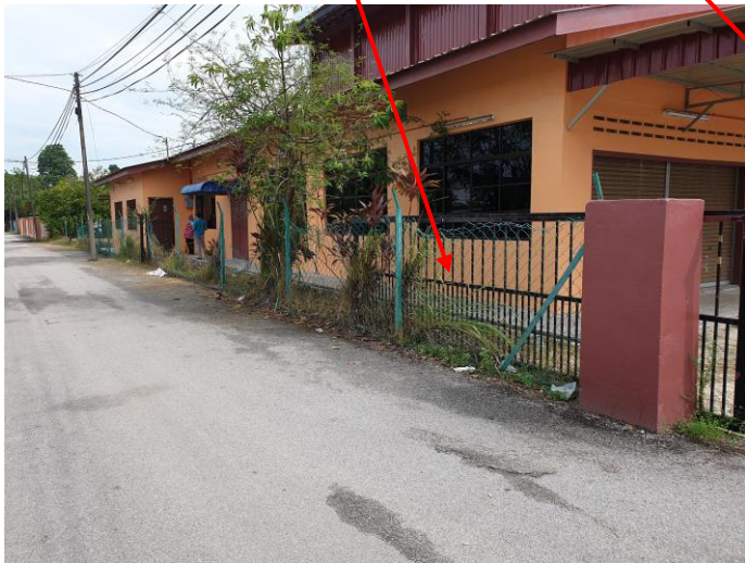
Pagar sedhada digantikan dengan pagar baru jenis 'welded mesh fence'
